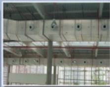
แผ่นพีโนลิกฟอยล์พร้อมอลูมิเนียมฟอยล์ ประกอบด้วยวัสดุหลักคือ แผ่นพีโนลิกฟอยล์ที่เพิ่มความแข็งแรงด้วย อลูมิเนียมฟอยล์ทั้งสองด้าน ที่เป็นพีโนลิกฟอยล์เป็นวัสดุในตัวไฟ ไม่มีครัน และไม่สามารถให้เกิดสารพิษเมื่อโดนผ้า โดยทนแรงดันได้ถึง 1 MPa และ ค่าน้ำค่าความร้อนค่าถึง 0.020 W/m·K ที่เป็นพีโนลิกฟอยล์สามารถติดเป็นห้องโดยไม่ต้องใช้กาว ขนาดและทากทุกปัจจัย สามารถใช้ ไฮดรอนิกส์ Central Air Conditioning ทั้งในโรงเรือน อาคารพาณิชย์ โรงงาน สำนักงาน และอาคารทั่วไปทุกชนิด
